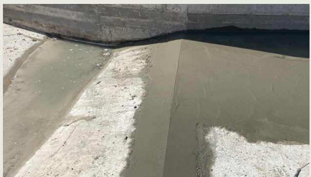
תמונה 4. יציקה של רצפה וקירות המתקן מבטון בתוך אפיק הנחל
