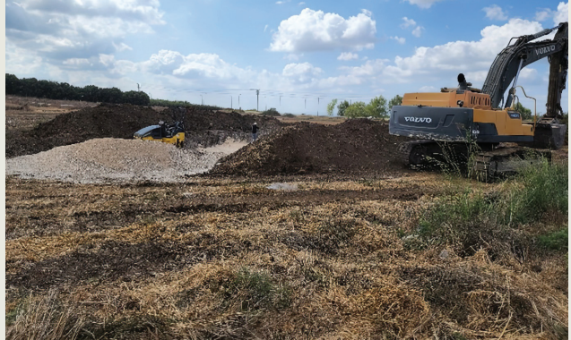
תמונה 3. חישוף וחפירת בתשתית אפיק הנחל לקראת בניית המתקן.
