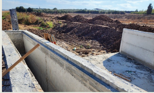
תמונה 5. דופן כפולה לצורך התקנת מכשירי מדידה
