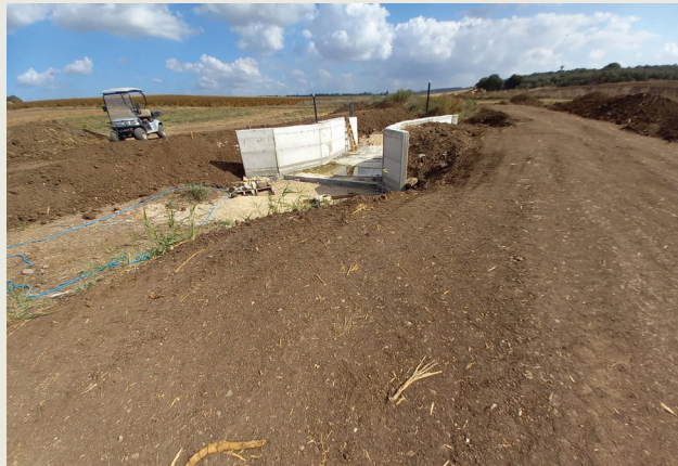
תמונה 6. סיום עבודות עפר ובנייה מחדש של גדות האפיק.
