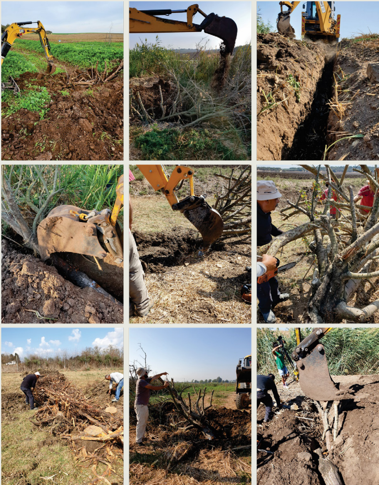
איור 9. תכנון שדה וביצוע המתקנים. שימת הלב לשימוש בגודלי הכפות השונים של המחפרון או המיני מחפרון; השימוש בכף ללחיצה אנכית או אלכסונית לתוך החריץ שנפתח מקומית עם עבודות עפר מזעריות ולחיצות של העץ אל תוך הקרקע.
