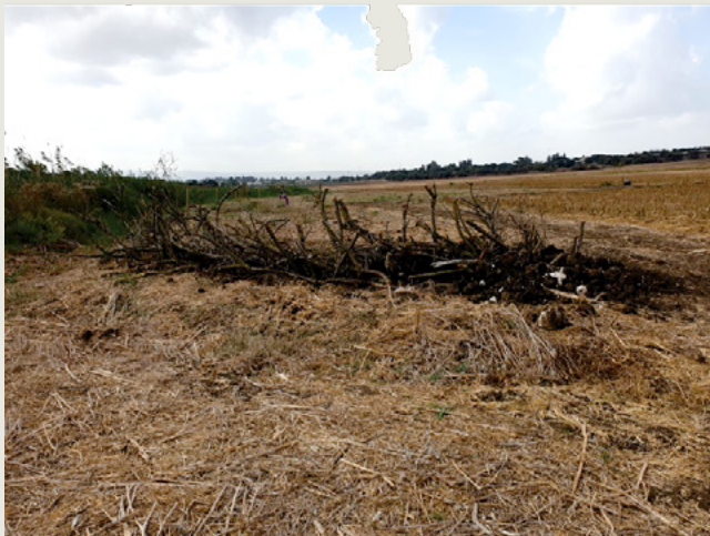
איור 10. עיגון וחיזוק המתקנים בהתאם למשקל של חומר הגלם המונח באפיק; תוספת של בולדרים בייצוב ראש ערוץ באמצעות חפירה וקבירה של גזע העץ, סירוג המבנה ומנח צפוף ומרועף.
